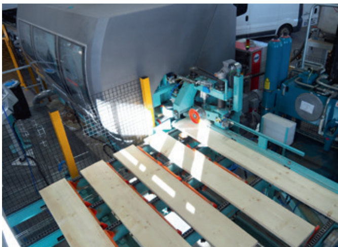
Die gekappten Hölzer werden in die Eurozink Compact-Anlage von Ledinek eingetaktet
